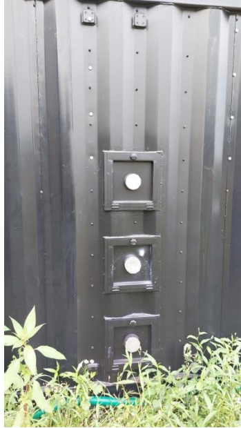
Abb. 9: Öffnungsklappen im Container zur Probenahme
