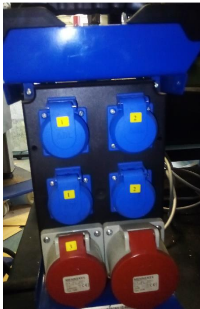
Abbildung 27: Installierter Stromverteiler.
