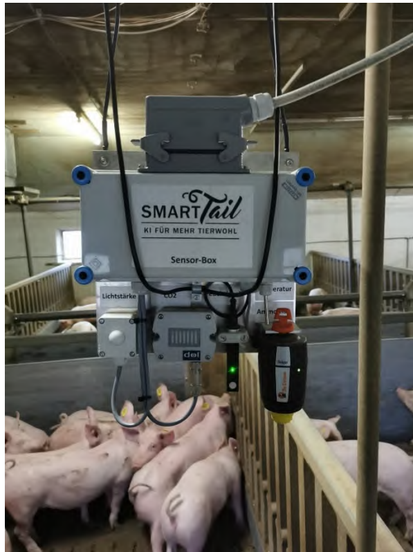
Abbildung 19: Im Stall installierte Sensorbox
