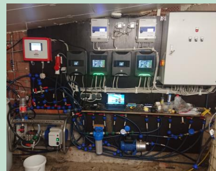
Bild 2: In einem Raum neben dem Stall befindet sich die Lüftungstechnik und die unterschiedlichen Hilfsmittel, mit denen der Sorbent dosiert und in den Stall eingebracht wird. Foto: Hochschule Osnabrück
