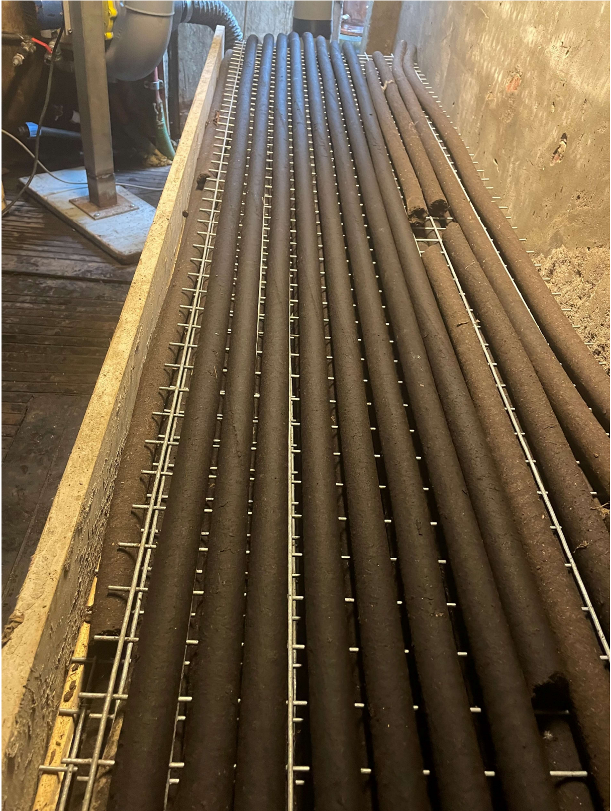
Fertige Rohre, rechts vor dem Umbau und links nach dem Umbau
