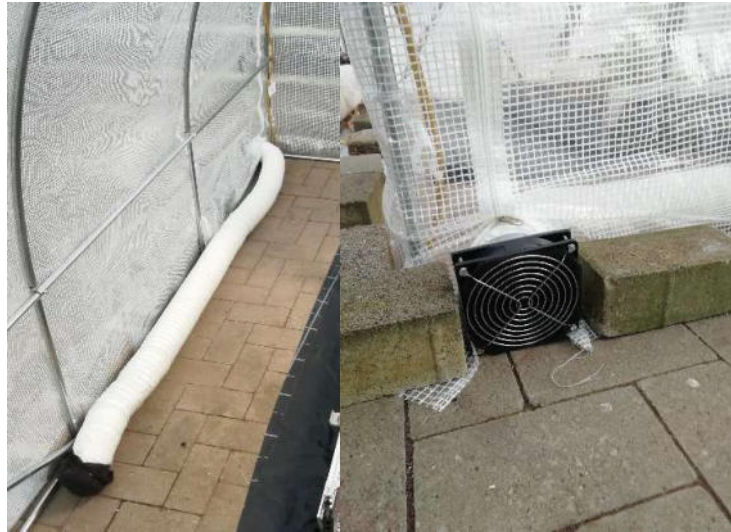
Abbildung 36: Belüftungssystem mit integriertem Aktivkohle-Filter
