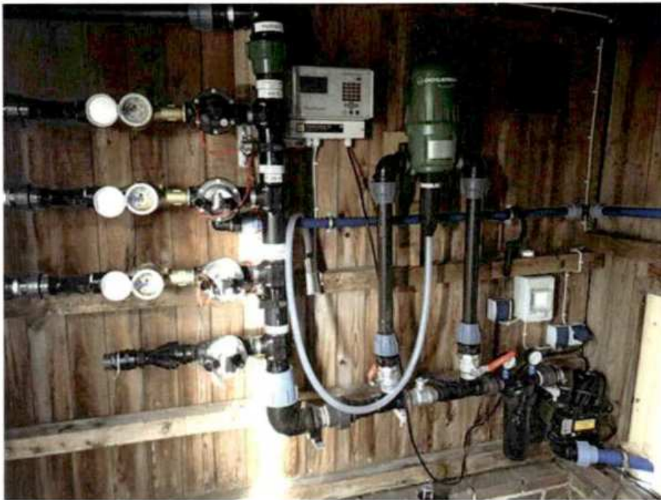
Abbildung 2.46: Verteilerstation für die 3 Parzellen
