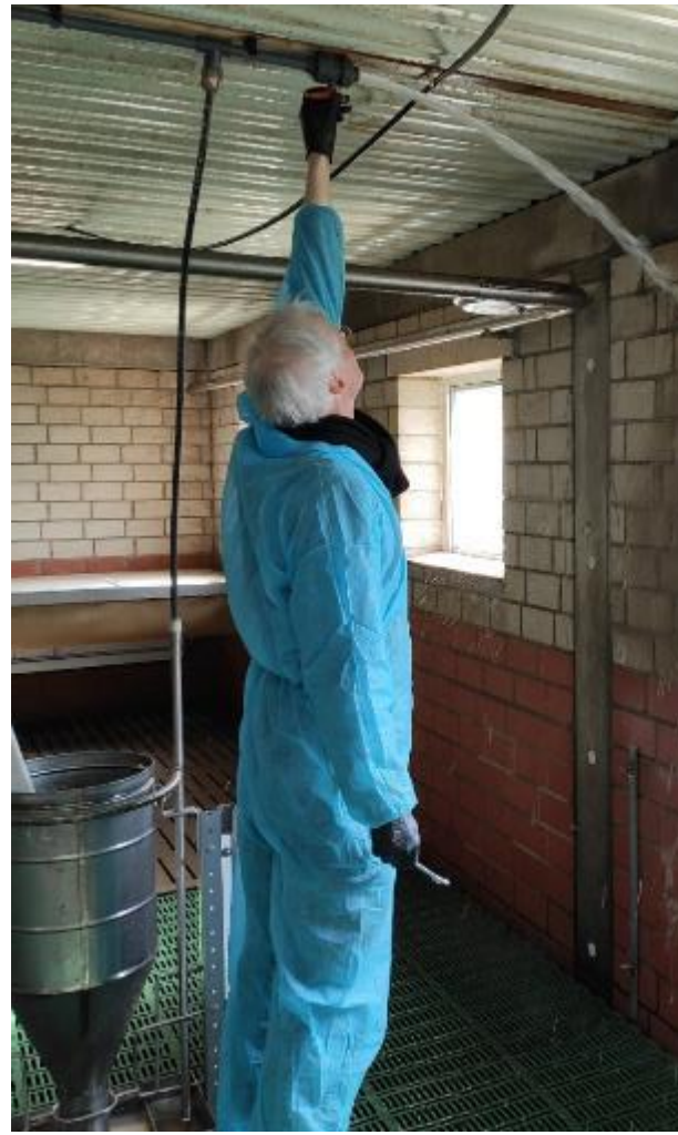
Abb. 6b. Entfernen der Reinigungslösung aus dem System nach der Stand- und Einwirkzeit
