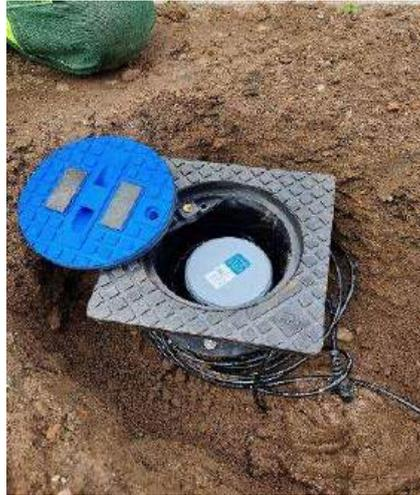
*Abbildung: Installation eines Tensiomark-Sensors und einer Funkbox der Fa. EcoTech (Projektextern) in der Schmiedestraße.*
