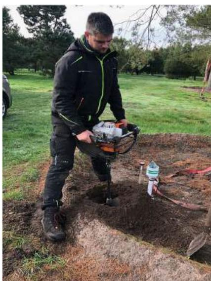
Abbildung: Bohren des Einbringungslochs
