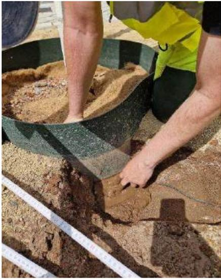
*Abbildung, 1: Gebohrtes Loch für den Sensor, 2: Jan Pinski in der Baumscheibe mit Climavi-Sensor und Abstandshalter, 3: Einfüllen der gemischten Schlämme aus gesiebttem Substrat, 4: Fertig eingeschlammter Sensor.*
