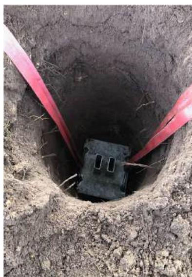
Abbildung: Ablassen der Einschlagführung
