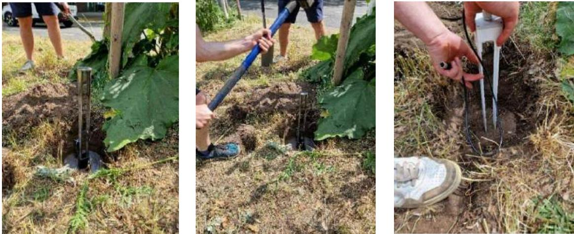
*Abbildungen: CLIMAVI-City Sensor-Einbau mit Einbringwerkzeug*
