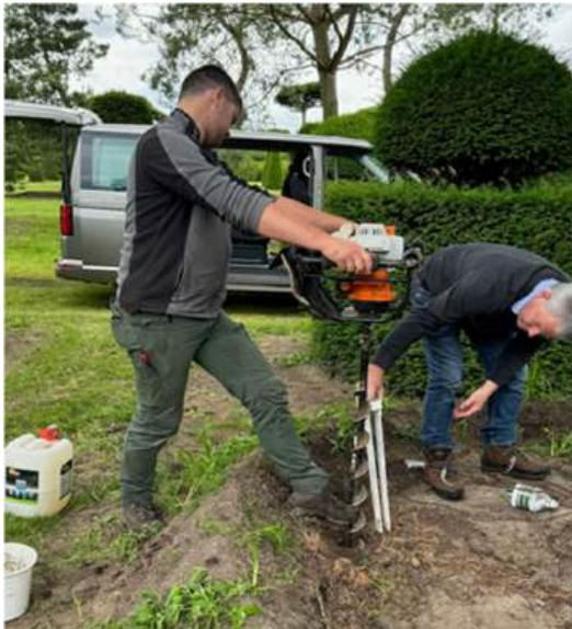
*Abbildung: Bohren (80mm) des Loches*
