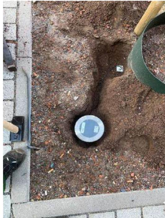
Abbildungen: NuTree Sensorinstallation am Standort Schmiedestraße. 1: Standortüberblick, 2: Aushub und Ausrichtung der Sensorgrube, 3: Einsetzen des Climavi-Sensor-Fußes, 4: Fertig installierter Climavi-Sensorfuß und /-City-Kopf
