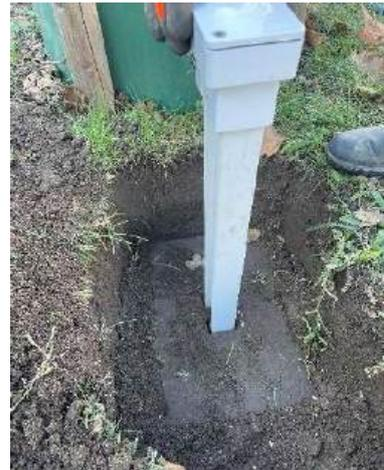
*Abbildungen: CLIMAVI-City Sensor-Einbau mit Einbringwerkzeug*
