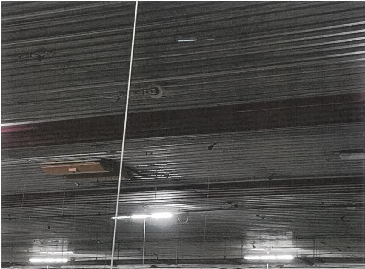
Abbildung 3: Doppelte Stalldecke mit Dunkelstrahlern (rot) und Zuluftöffnungen (orange)
